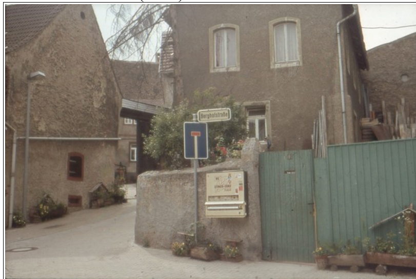
Abgerissenes ehemaliges Posthaus, Berghofstraße (Heck)
